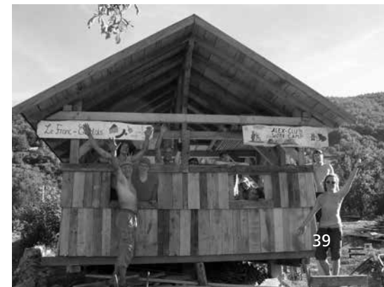
Geschafft, unsere Hütte steht!
